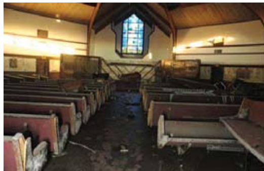
Un templo adventista dañada por las inundaciones en New Orleans
